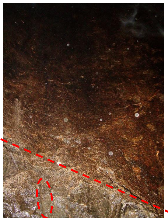
Fig. 1. Spår efter de två brytningsmetoderna i schaktet RAÄ 79. Förutom skillnad i struktur kan borrhål iakttas (inringat på bild). Tillmakning syns ovanför och sprängning nedanför streckmarkeringen.
